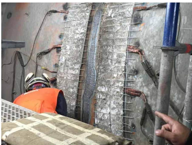
Labores de reparación de fisura en Molino Unitario N°2
