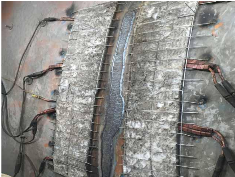
Trabajo de Reparación en Molino Unitario N°2
